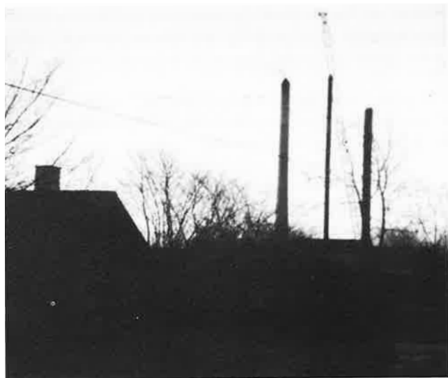
Fotoet viser opsætningen af stålskorstenen, hvor man på et tidspunkt under opsætningen altså havde ikke mindre end 3 skorstene på værket.
